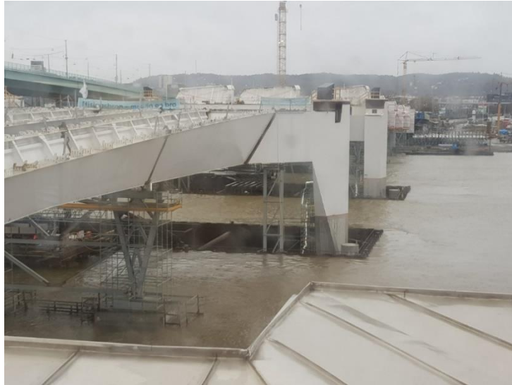
Figur 6-9: Byggnation av nya Hisingsbron under stormen Dennis, februari 2020. Vattennivån motsvarade ett högvatten med i storleksordning 10 års återkomsttid.
